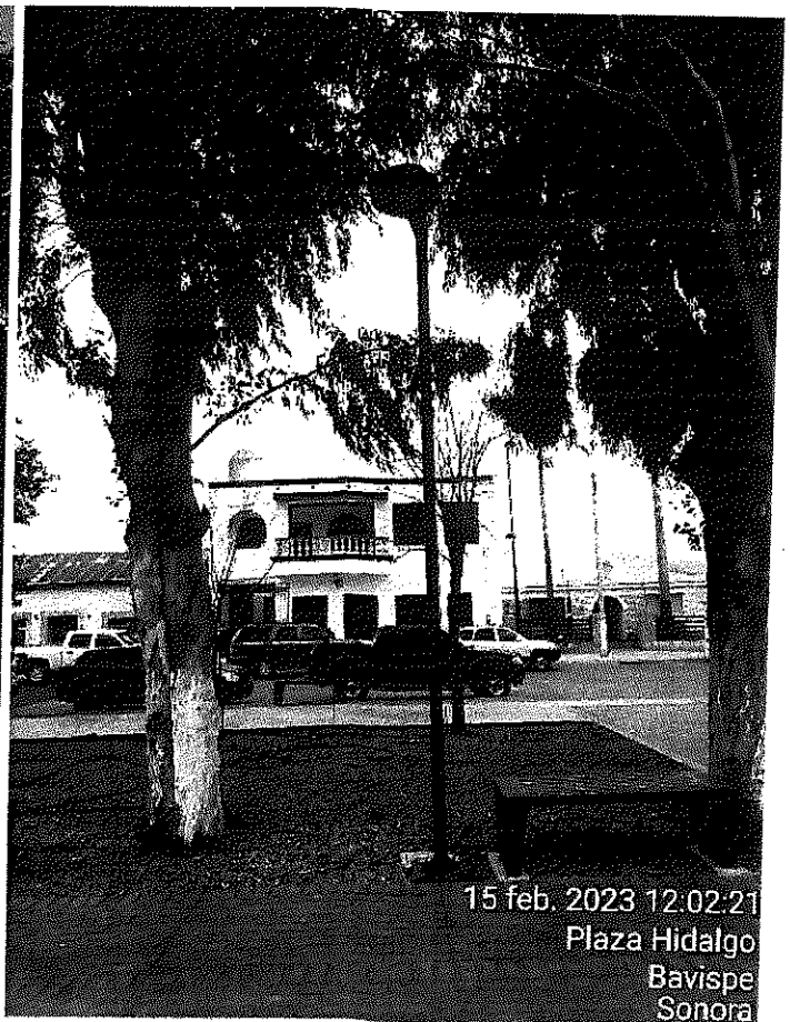
LUMINARIA PEATONAL (24 PIEZAS), INTEGRADA A POSTE DE ACERO DE 5 M DE ALTURA.
