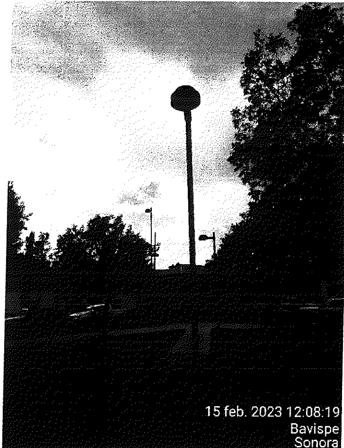
LUMINARIA PEATONAL (24 PIEZAS), INTEGRADA A POSTE DE ACERO DE 5 M DE ALTURA.
